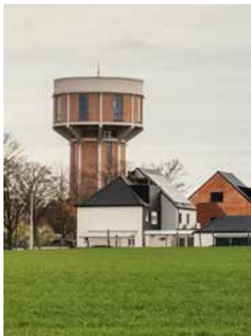
De watertoren van Ferdi in Steenokkerzeel.
